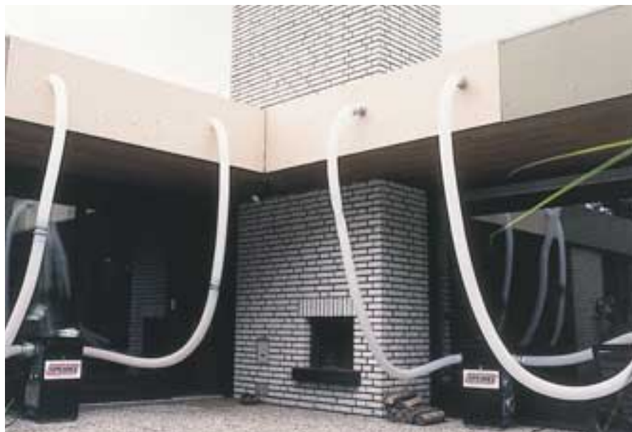
Kaltdachtrocknung ohne Zerstörung der Dachhaut und der Zimmerdecke
